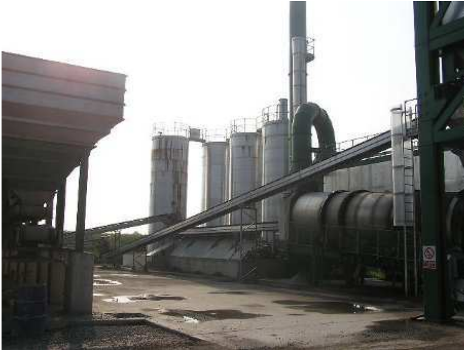
Figura 2-8 – Impianto di pretrattamento (essiccatore).
