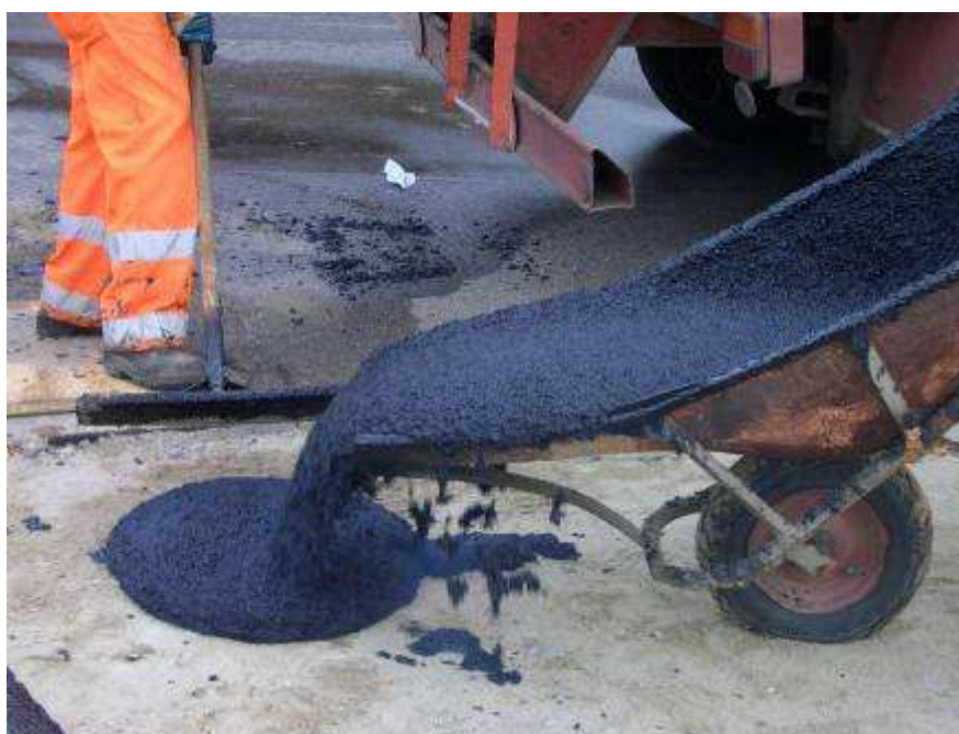
Figura 4-5 – Stesa di asfalto colato su marciapiede.
