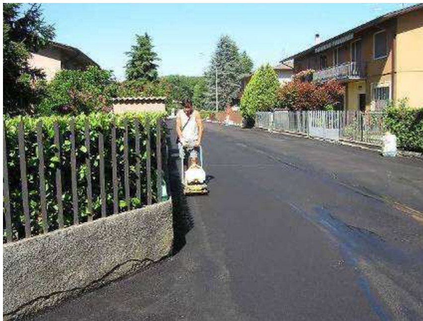
Figura 3-7 – Compattazione asfalto con piastra vibrante.
