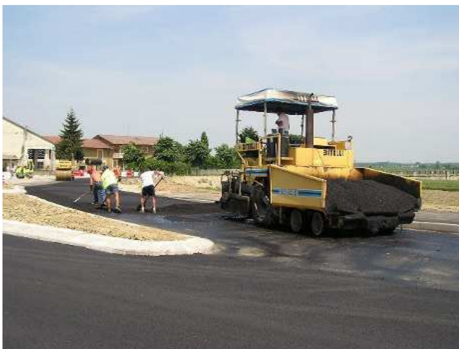
Figura 3-4 – Stesa asfalto con vibrofinitrice.
