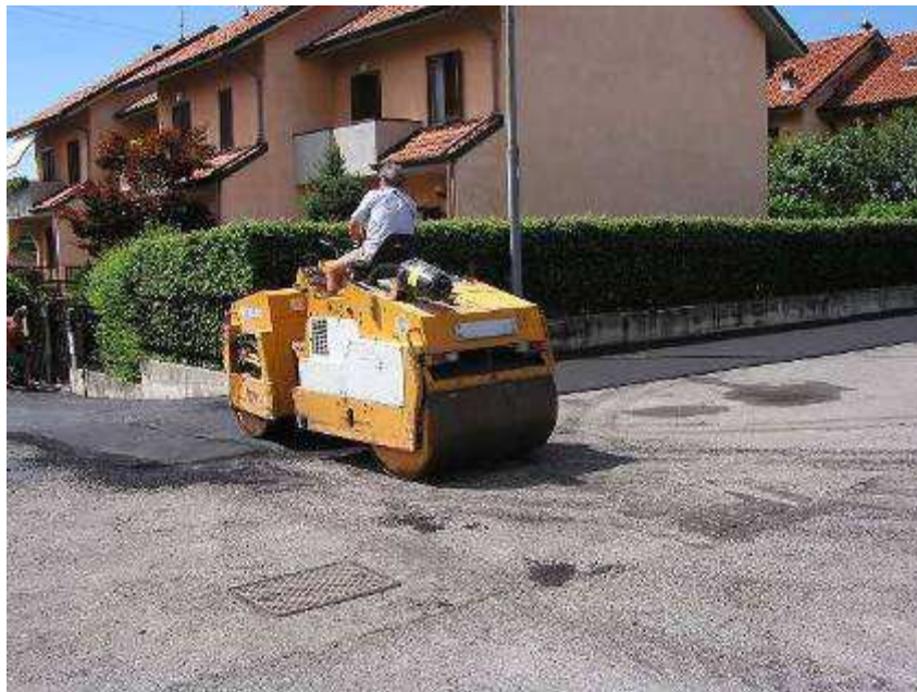
Figura 3-6 – Compattazione asfalto con rullo.
