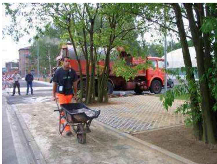
Figura 4-4 - Trasporto di asfalto colato con carriola.
