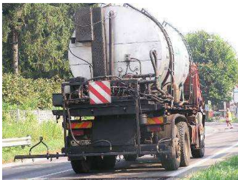
Figura 3-2 – Applicazione emulsione bituminosa automatica.
