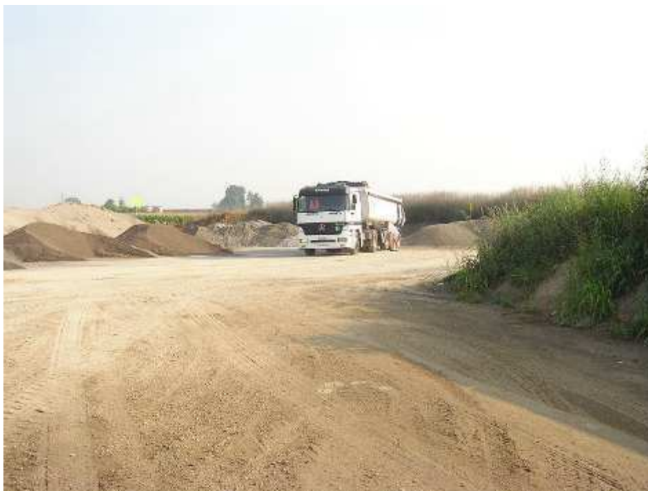
Figura 2-1 – Arrivo inerti allo stabilimento di produzione.
