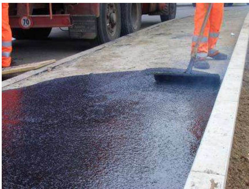
Figura 4-6 – Stesa di asfalto colato su marciapiede.
