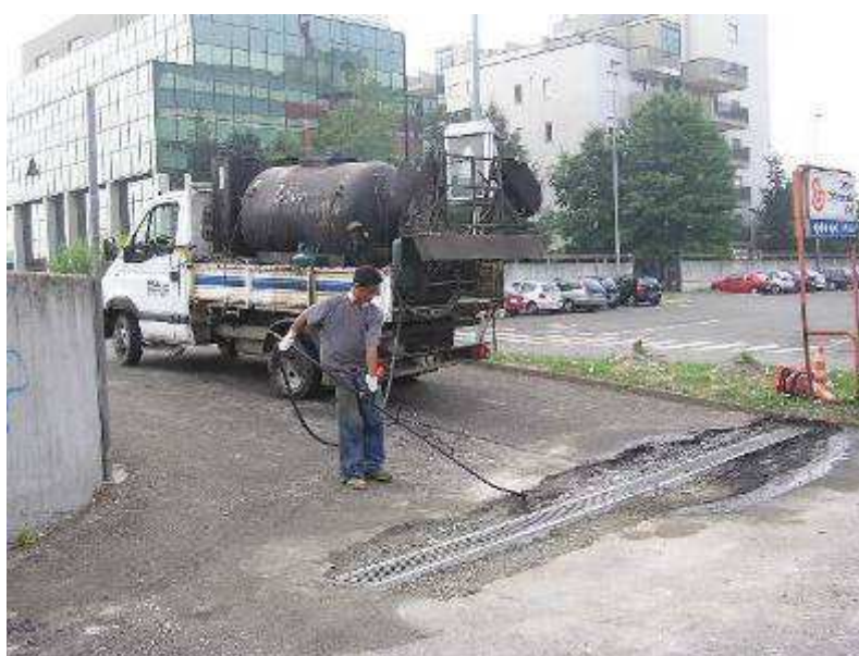
Figura 3-3 – Applicazione emulsione bituminosa manuale.
