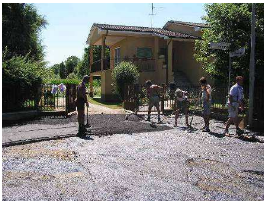
Figura 3-5 – Stesa asfalto manuale.
